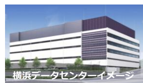
横浜データセンターイメージ
